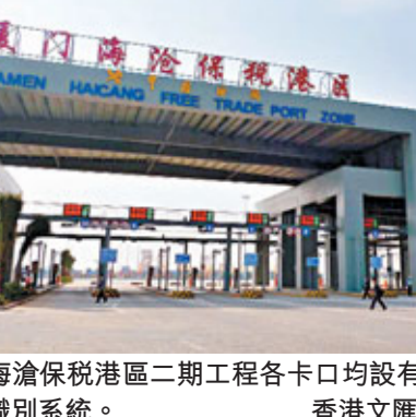
海滄保稅港區二期工程各卡口均設有集裝箱及車牌自動識別系統。
