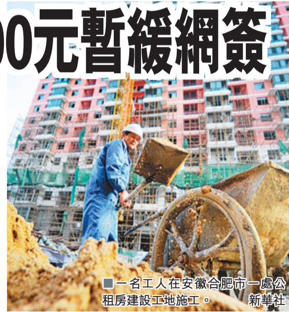
一名工人在安徽合肥市一處公租房建設工地施工。
