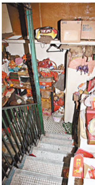
■通上天台梯間堆滿雜物。
