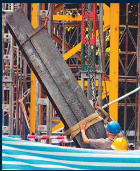
■消防借用地盤天秤將工字鐵吊起救人。
