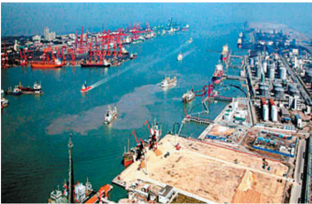
■加緊建設中的天津濱海東疆保稅港區
