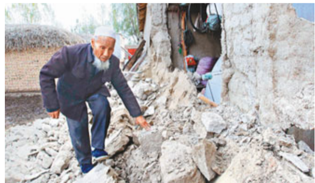
新疆伊犁新源縣村民保玉林在查看地震中受損的自家房屋。新華社
