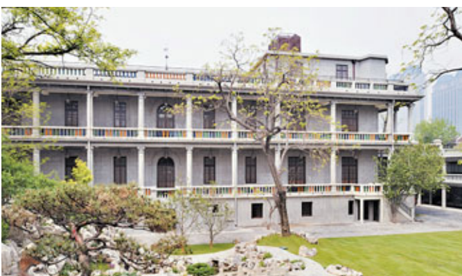
■修舊如故的慶王府院內一隅。資料圖片
