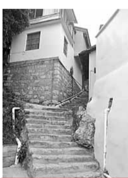
■白草村自建污水排放系統進行雨污分流，圖中白色的管子就是村民家中排放生活污水的管道。
