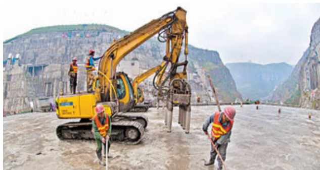
■建設者們正在對9號壩段進行收倉 王連生攝
