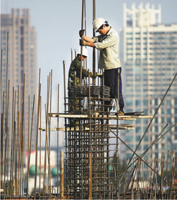
■9月內地70個大中城市中，46個城市樓價停漲。圖為湖北武漢某在建樓盤。
