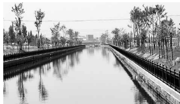
入滇河道寬槽河整治後
