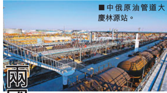
中俄原油管道大慶林源站。
