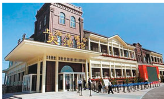
■ 以天津小洋樓造型為外觀的上海世博天津館
