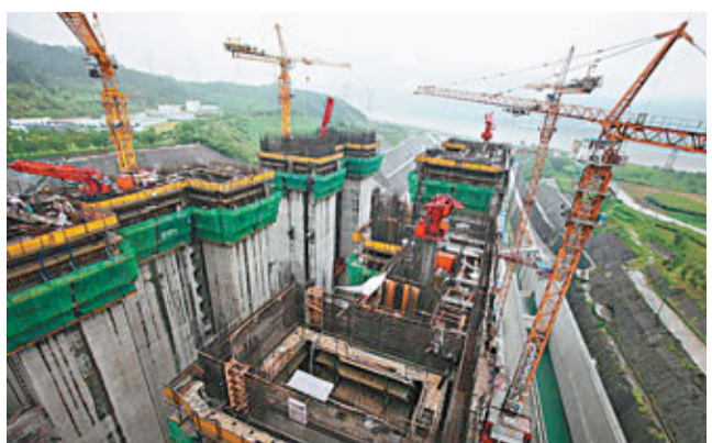
■8月23日，已突破175米高程的三峽升船機施工現場全貌。
