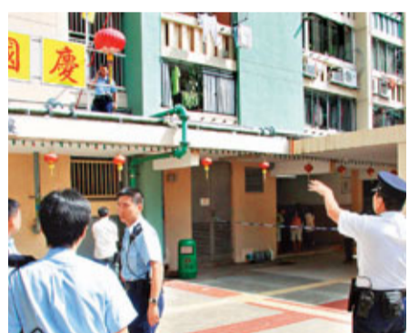
■發生清潔工人自簷篷墮下的愛民邨並未安裝「平行安全鋼索防墜系統」。
