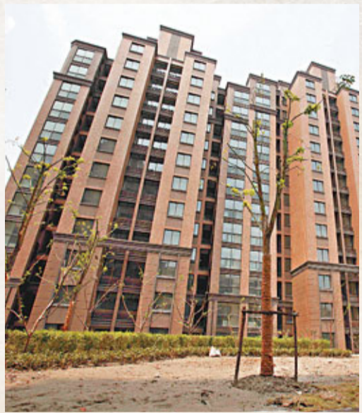
上海松江泗涇3000餘套保障房9月交付使用。新華社
