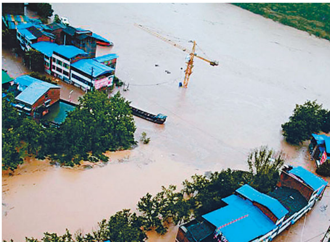
■巴河洪水漫過四川省巴中市平昌縣城,工地的塔吊被攔腰淹過。
