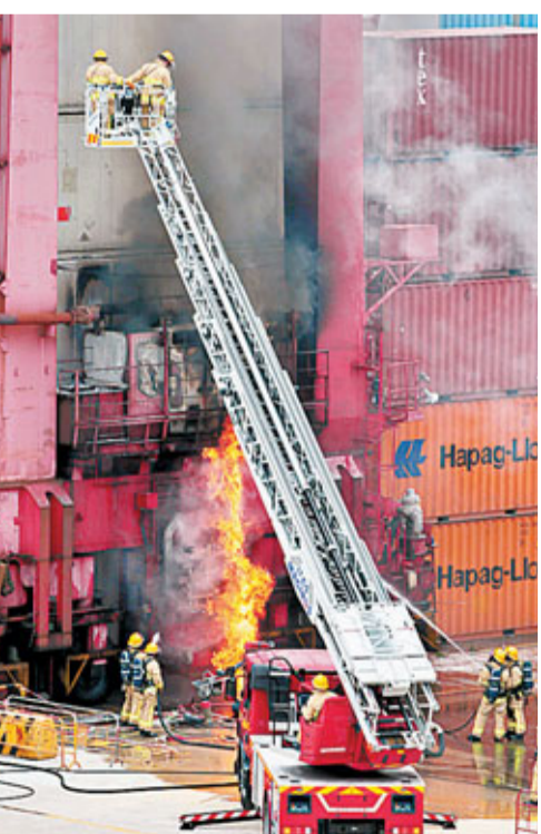
「怪獸」噴火 香港文匯報訊 (記者 杜法祖) 葵涌貨櫃碼頭一部俗稱「怪獸」的巨型吊機，昨午1時許操作期間疑因電箱機件過熱噴火，在離地20多米高駕駛艙內的操作員一度被困，消防員到場除開喉及噴化學泡沫撲救外，並架起雲梯將被困操作員救離險境，吊機機件遭焚毀，無法再移動及運作。
