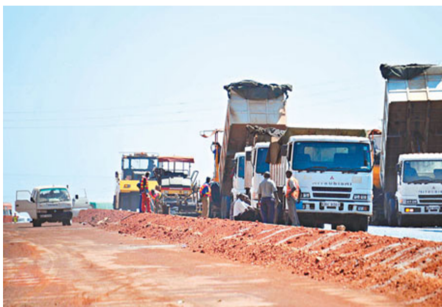
中國水利水電以工程承包為核心業務。圖為該公司在肯亞修建的內羅畢—錫卡高速公路。
