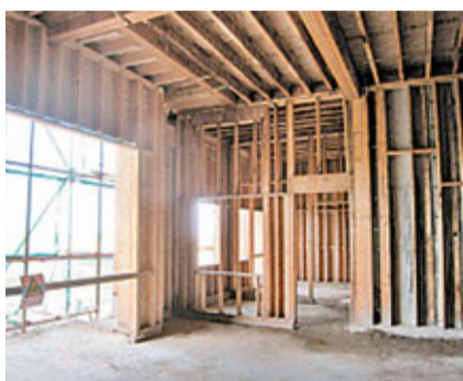
純木公寓內部結構
