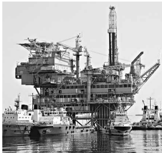
發生漏油事故的蓬萊19-3油田C平台。
