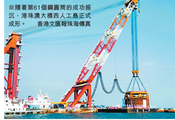
隨著第61個鋼圓筒的成功振沉,港珠澳大橋西人工島正式成形。 香港文匯報珠海傳真
