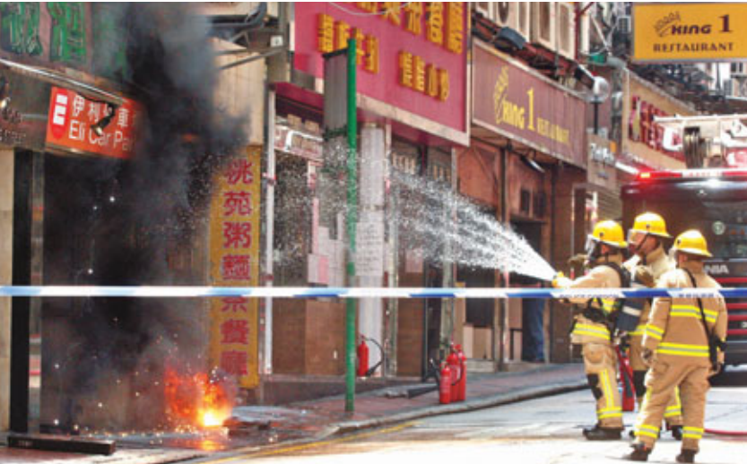
■德興街路邊地底電纜噴火，消防員開喉灌救。
