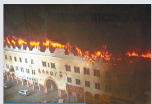
哈爾濱電腦城火災 25日14時左右,位於哈爾濱市區內的南通電腦城發生火災,消防部門趕往現場救援。事故已造成3人死亡。 中新社
