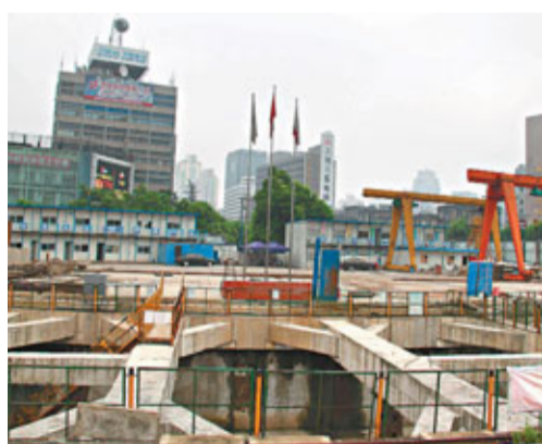
■杭州地鐵施工現場。
