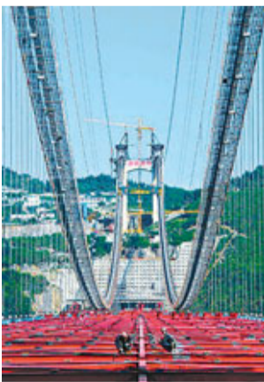
湖南湘西矮寨大橋的鋼桁(音恒)樑合龍。
