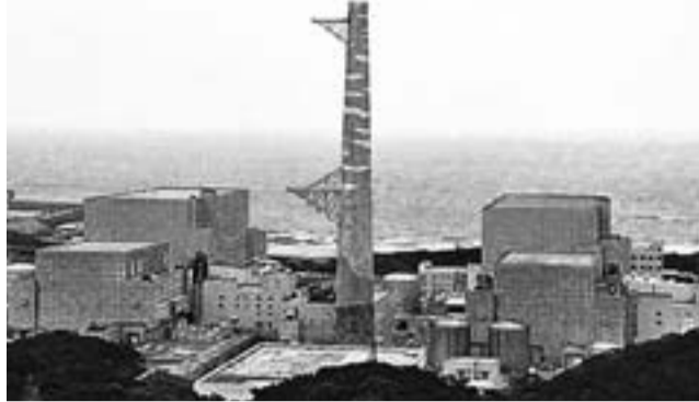
核四廠日前發生漏水、積水事故。資料圖片
