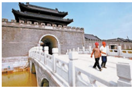
建設中的北塘古鎮
