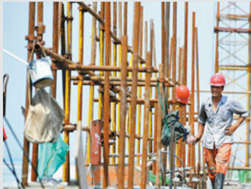
二線城市房價領漲，保障房建設更加舉足輕重。圖為在持續高溫的合肥市，公租房建設工地仍在加緊施工。
