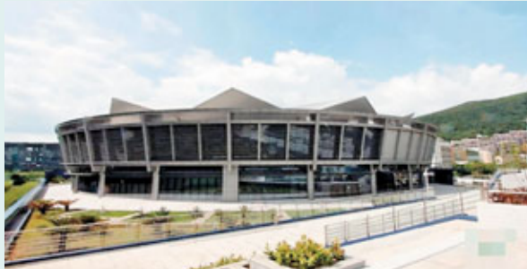
鹽田區綜合體育館分賽場。
