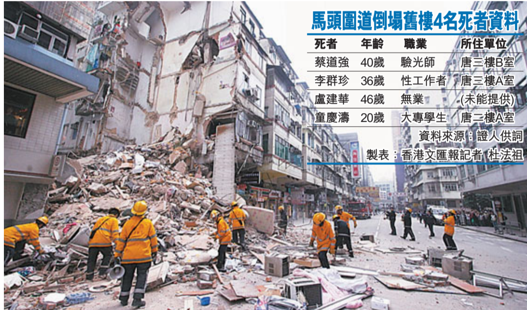
馬頭圍道唐樓全幢倒塌，引致4人死亡。
