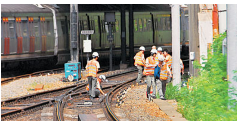
大批工程人員在路軌上搶修訊號系統。
