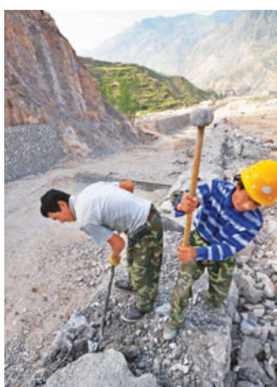
■兩名工人在舟曲縣泥石流重力攔擋工地上施工。 新華社
