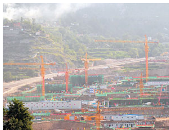
■舟曲縣城重建工地景象。 新華社
