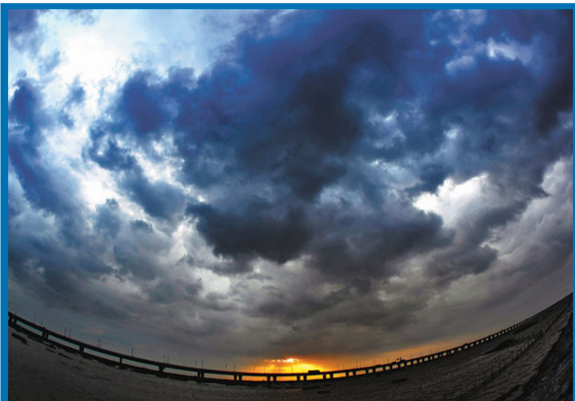
■隨着強颱風「梅花」趨近,浙江杭州灣跨海大橋風雨欲來。圖為6日,杭州灣跨海大橋上空烏雲密布。
