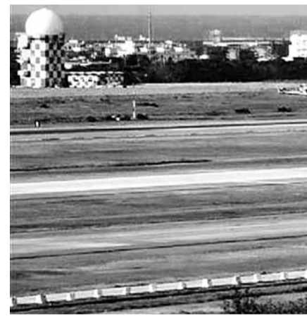
■桃園機場跑道使用超過20載，已非常破舊，當局經常修補。
