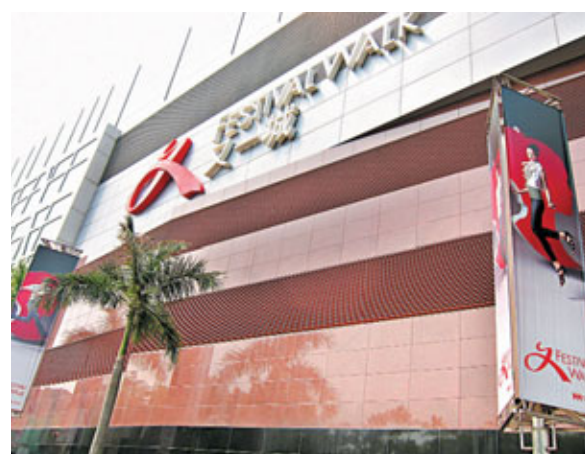
新加坡淡馬錫旗樓下豐樹產業以188億元向太古地產購入又一城全部權益。
