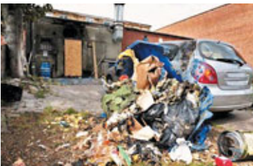
■中餐廳後門損毀嚴重。
