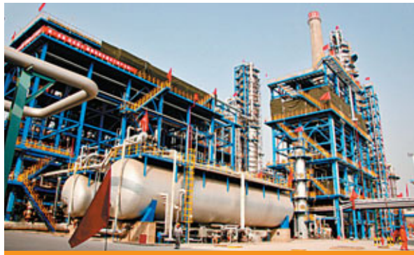
■公司新建的550常減壓裝置 劉延治攝
