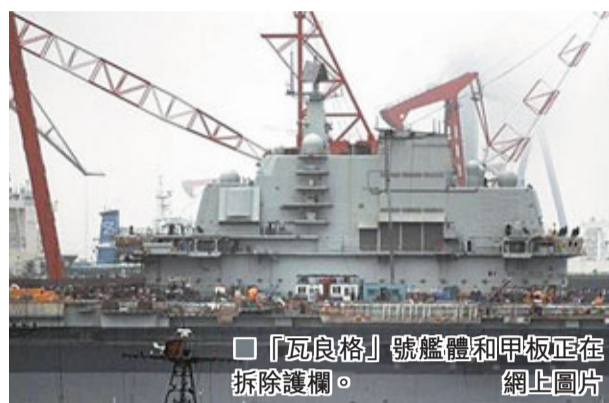
「瓦良格」號艦體和甲板正在拆除護欄。網上圖片
