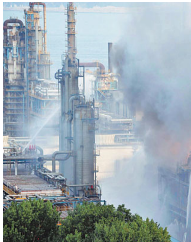
■16日14時25分,中國石油大連石化公司廠區內1000萬噸常減壓蒸餾裝置換熱器發生泄漏並引起大火。截至18時許,火情得到控制。新華社
