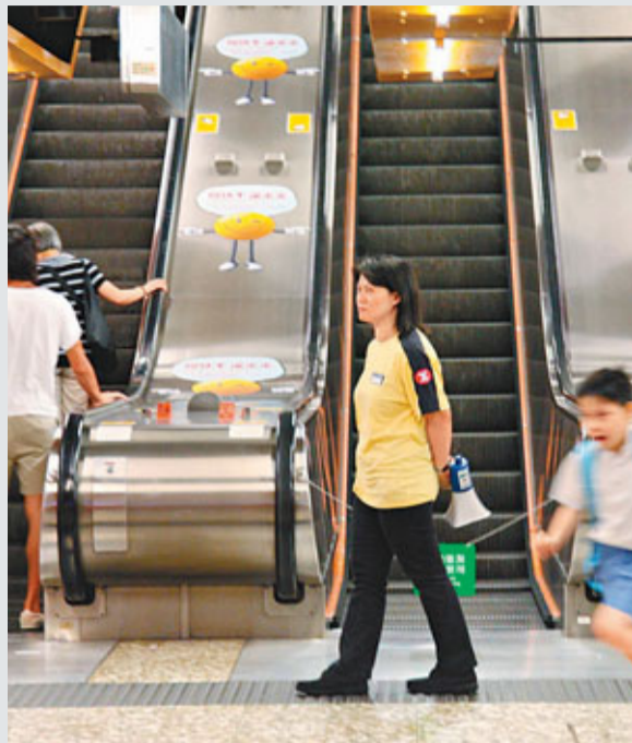
巡視扶手電梯 港鐵人員昨巡視扶手電梯,並用擴音喇叭提醒乘客緊握扶手。機電工程署在北京地鐵發生扶手電梯意外後,即時要求電梯承辦商及港鐵展開全面檢查。香港有78條同類扶手電梯,當天中午完成檢查。 中通社
