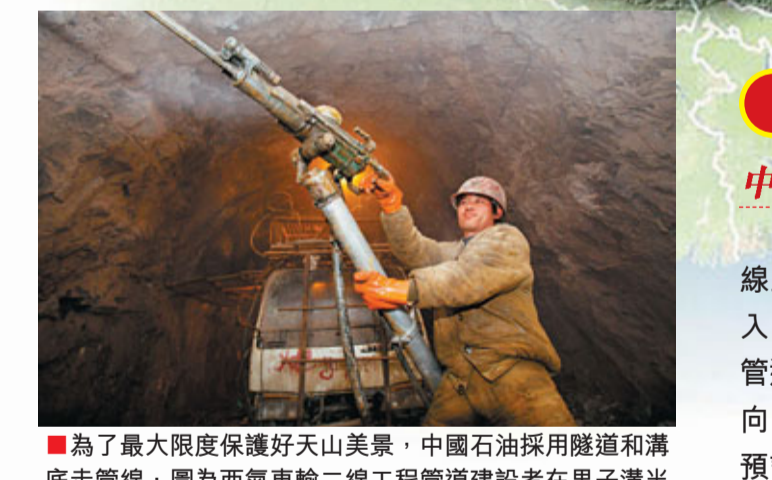
為了最大限度保護好天山美景，中國石油採用隧道和溝底定向鑽，圖為西氣東輸二線工程管道建設者在果子溝山峽進行定向鑽。
