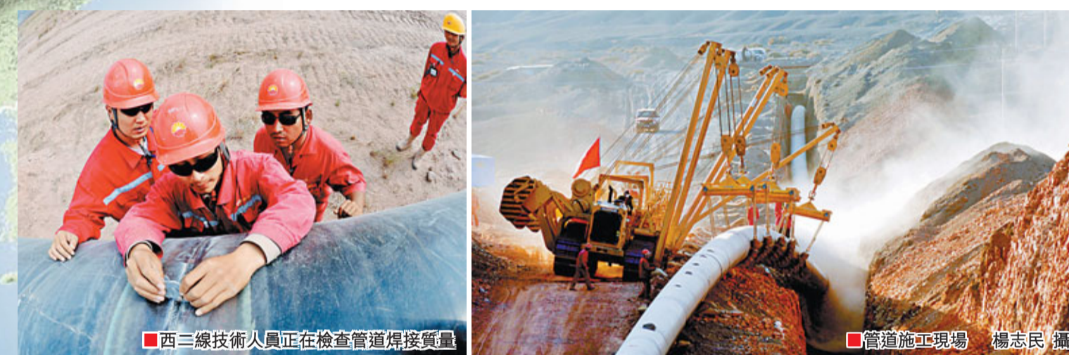
西二線技術人員正在檢查管道焊接質量。管道施工現場。
