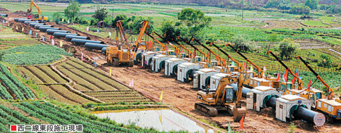
西二線東段施工現場。
