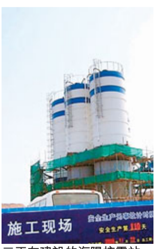
正在建設的海陽核電站。
