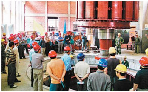
重慶機電生產的水輪發電機正在阿鳩田電站安裝
