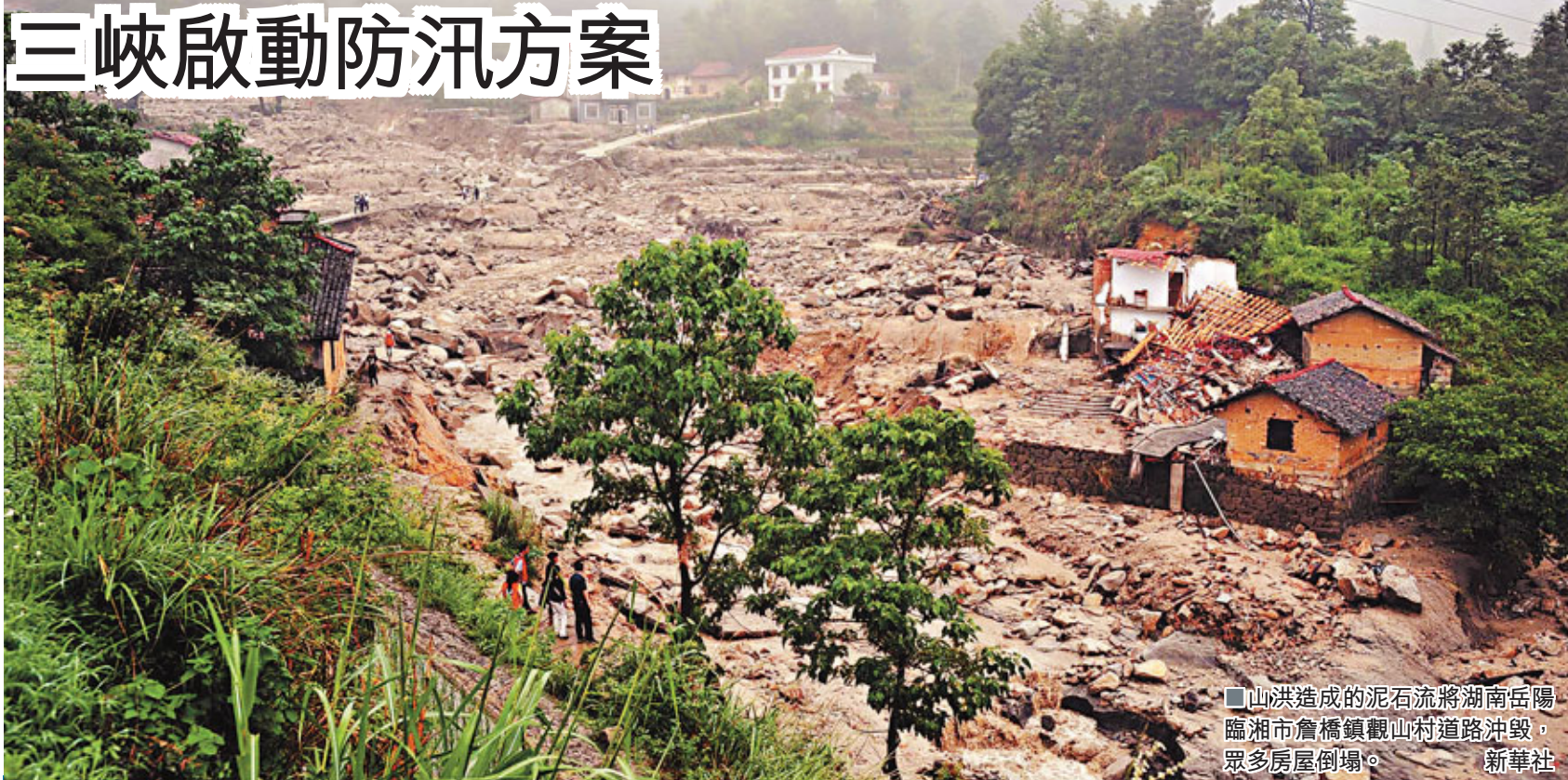
山洪造成的泥石流將湖南岳陽臨湘市詹橋鎮觀山村道路沖毀，眾多房屋倒塌。 新華社
