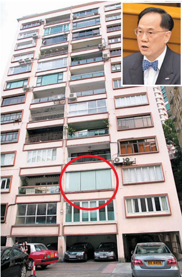
■曾蔭權(小圖)發表聲明說，為消除一切疑慮，將根據屋宇署的勸喻，安排盡快清拆麥當勞道碧雲樓2樓單位露台的玻璃嵌板(紅圈)。
