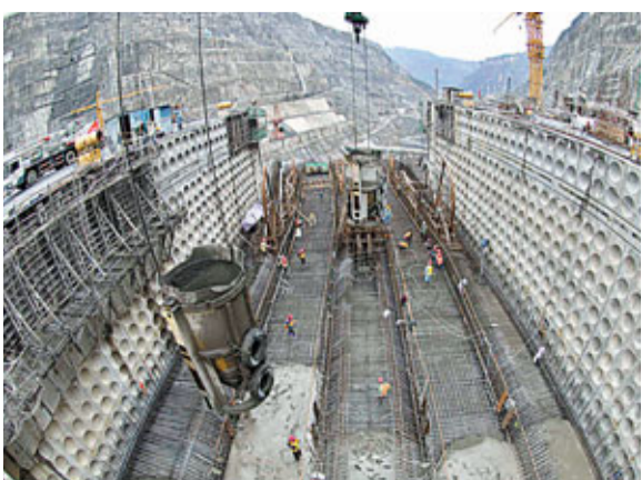
溪洛渡大壩混凝土澆築 王連生攝
