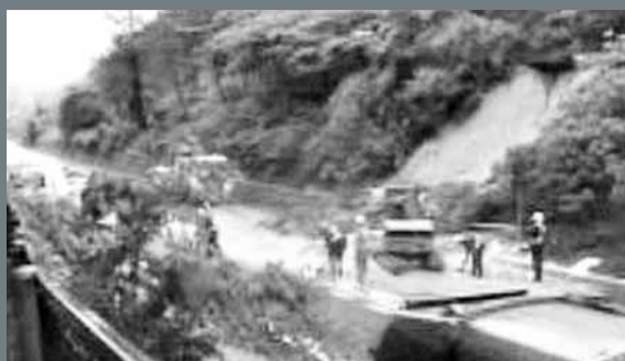
■京都京田邊市一段高速公路山泥傾瀉。電視圖片
