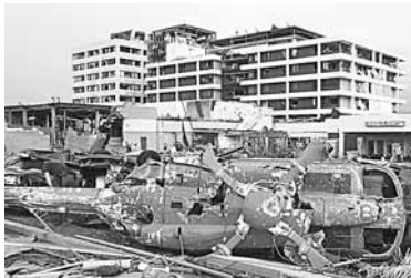
喬普林市醫院嚴重損毀，救援直升機如廢鐵般倒臥在停車場。美聯社
