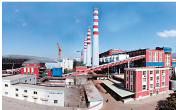
■大唐國際發電股份有限公司北京高井熱電廠。
