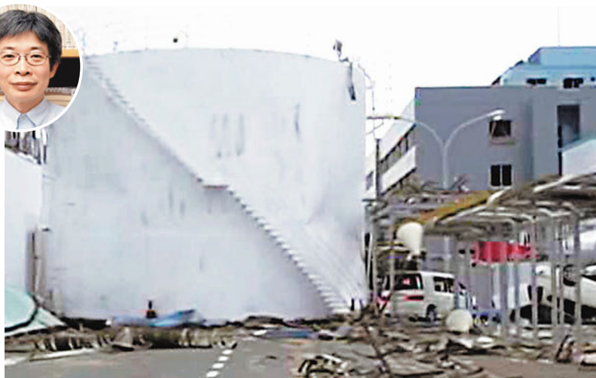
東電發放的片段顯示，海嘯把一個大型儲油罐掀翻，倒在核電站附近。 ■美聯社
